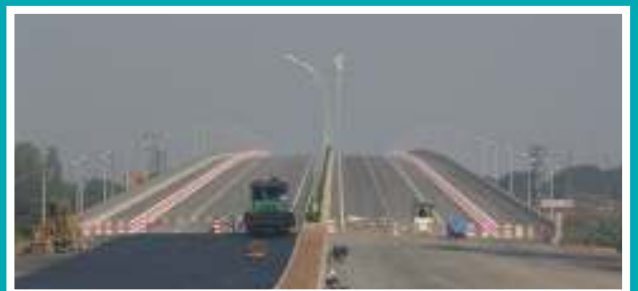
Công trình cáp trên cầu Cable project on bridges
