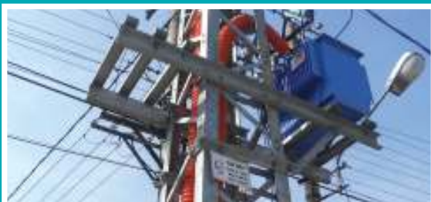
Công trình cáp nổi Overhead installation project
