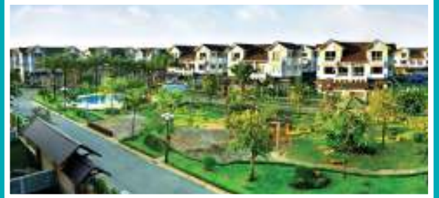
Hệ thống cáp tại khu đô thị Cable system in urban area
