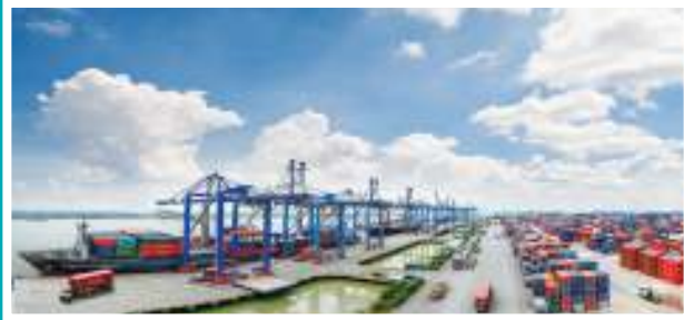
Hệ thống cáp ngầm tại cảng Underground cable system in ports
