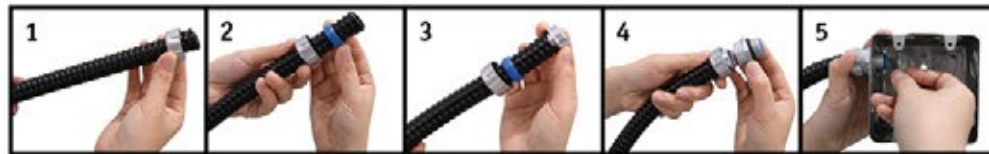
Hướng dẫn cách lắp đặt đầu nối Ống Ruột Gà với Hộp Điện DNCK
